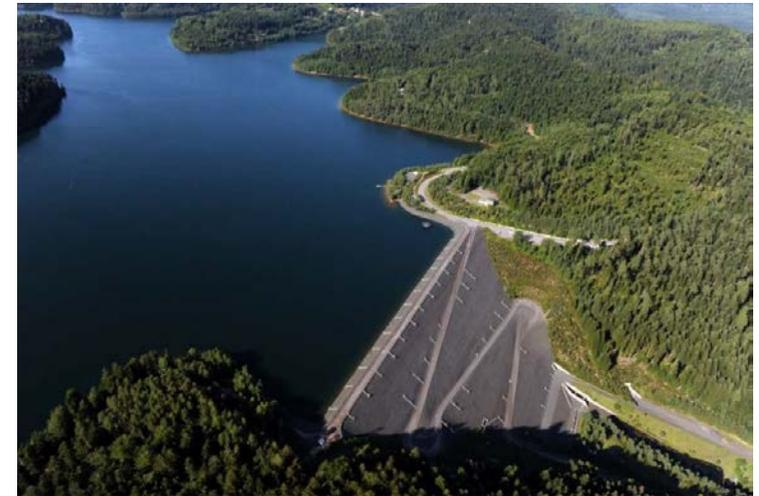
**Seine Funktion:** Ausgleich für das in den Kühltürmen verdampfte Wasser bei einem Abfluss der Mosel vor dem Standort  $< 26 \text{ m}^3/\text{s}$ , um den natürlichen Abfluss an der luxemburgischen Grenze zu gewährleisten
