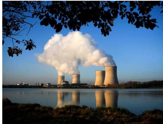
**Son rôle :** retenue artificielle qui assure le refroidissement des installations en cas de perte de liaison avec la Moselle et joue également un rôle de tampon thermique.
