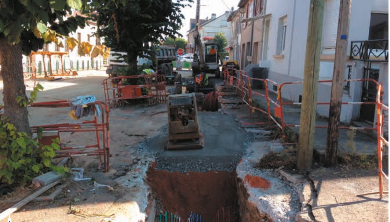
Rémyilly Requalification de la rue de Pont-à-Mousson - Maître d'œuvre: VRI
