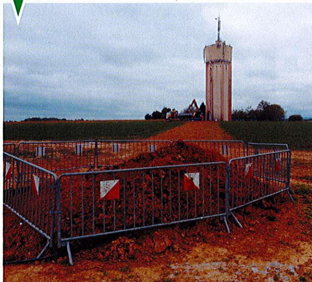
Syndicat des Eaux de Lorquin-Gondrexange Réhabilitation du réservoir d'eau potable - Maître d'œuvre: Berest
