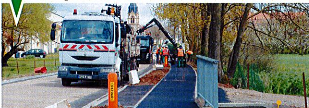
Pagny-lès-Goïn Aménagements de sécurité
