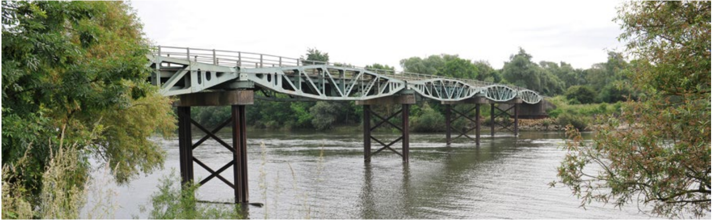
Oben: Die Moselbrücke zwischen Cattenom und Koenigsmacker (auf der Departementstraße RD 56) wird durch ein zweispuriges Bauwerk ersetzt.
