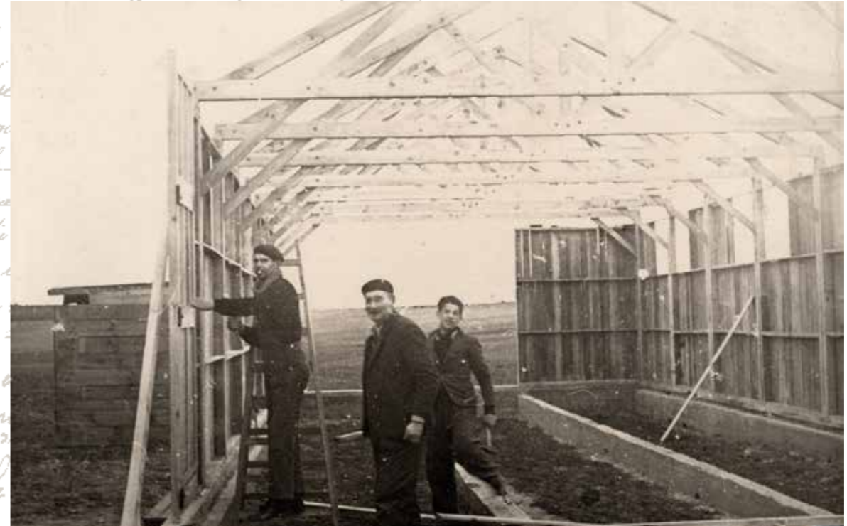
Construction d'un baraquement par des réfugiés mosellans à Saint-Georges-lès-Baillargeaux (Vienne) Coll. Léopold Nennig
